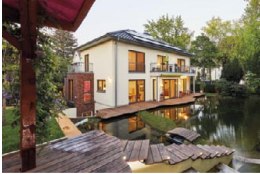
Vom erhöht liegenden Pavillon führen mehrere Stufen zum Teich und der kleinen Brücke mit Landzunge.
