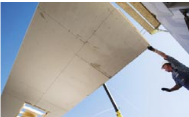
Die Geschosdecken und das Dach werden in Großelementen vorgefertigt mit Hilfe des Krans aufgelegt und montiert.
