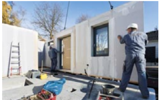
Millimeterarbeit: die Wände werden an den vorher markierten Positionen ausgerichtet und verankert.
