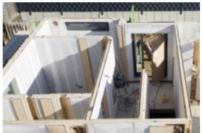
Innerhalb weniger Stunden werden auf diese Weise komplette Stockwerke zusammengebaut.
