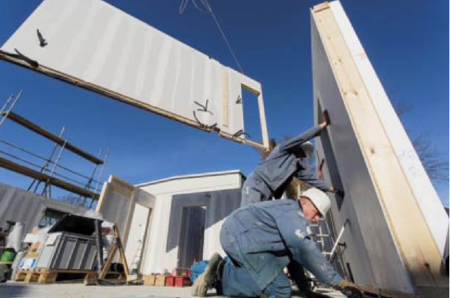
Beeindruckendes Schauspiel: Bei der Montage der Wände geht es Schlag auf Schlag. Mittags steht das Erdgeschoss.
