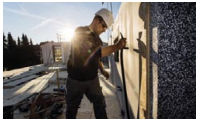
Wenn das Dach gedeckt ist, beginnt alsbald der Innenausbau und die Tage bis zum Einzug lassen sich zählen.
