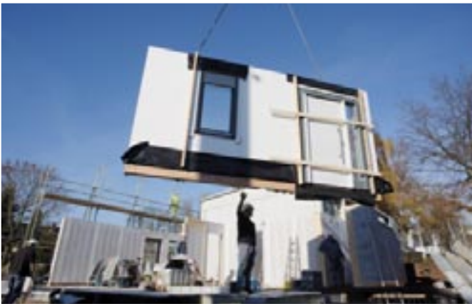
Ein Schwerlastkran hievt die Wände vom LKW. Wichtige Teile wie Fenster und Türen sind bereits montiert.
