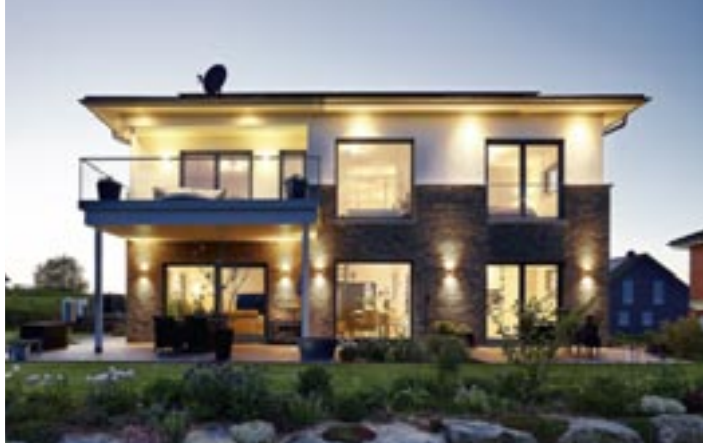
Blickfang in der Dämmerung und bei Dunkelheit: die effektvolle Beleuchtung der Fassade.
